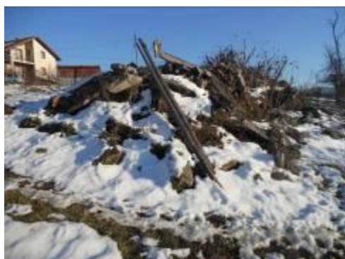
Gornji Ivančići (porušeni objekat)
